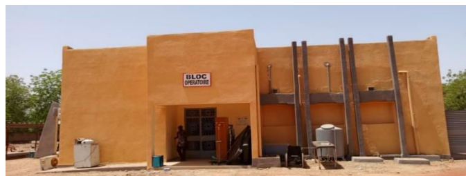
Figure 5: Bloc opératoire dont la détérioration est dénoncée en juillet 2023, rénové par les autorités grâce au plaidoyer OCASS et remis en service en avril 2024
